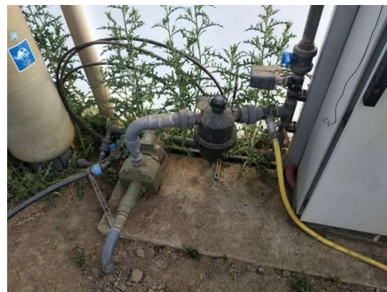
Figure 6 systèmes de pompage relié à 2 X 5 000L
